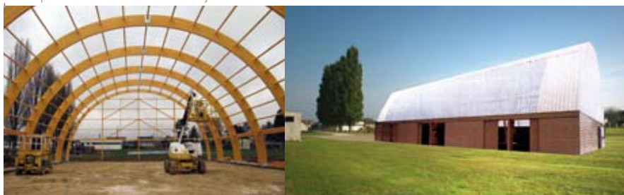
Charpente en lamellés collés à Sonzay Nov.2008
